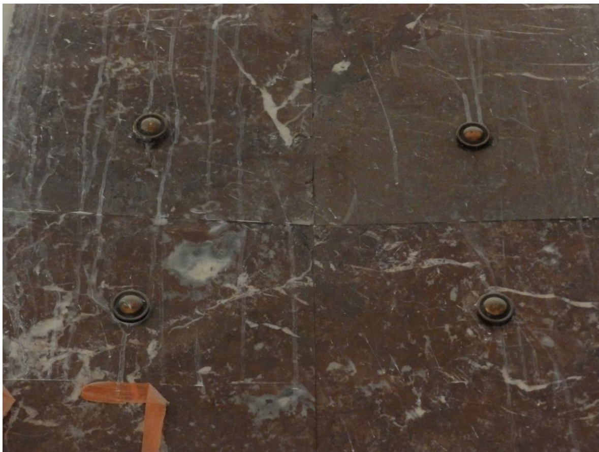
Obrázek 23: Měděné terče před restaurováním
