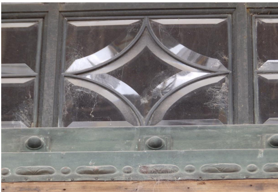
Obrázek 18: Detail poškozeného zasklení
