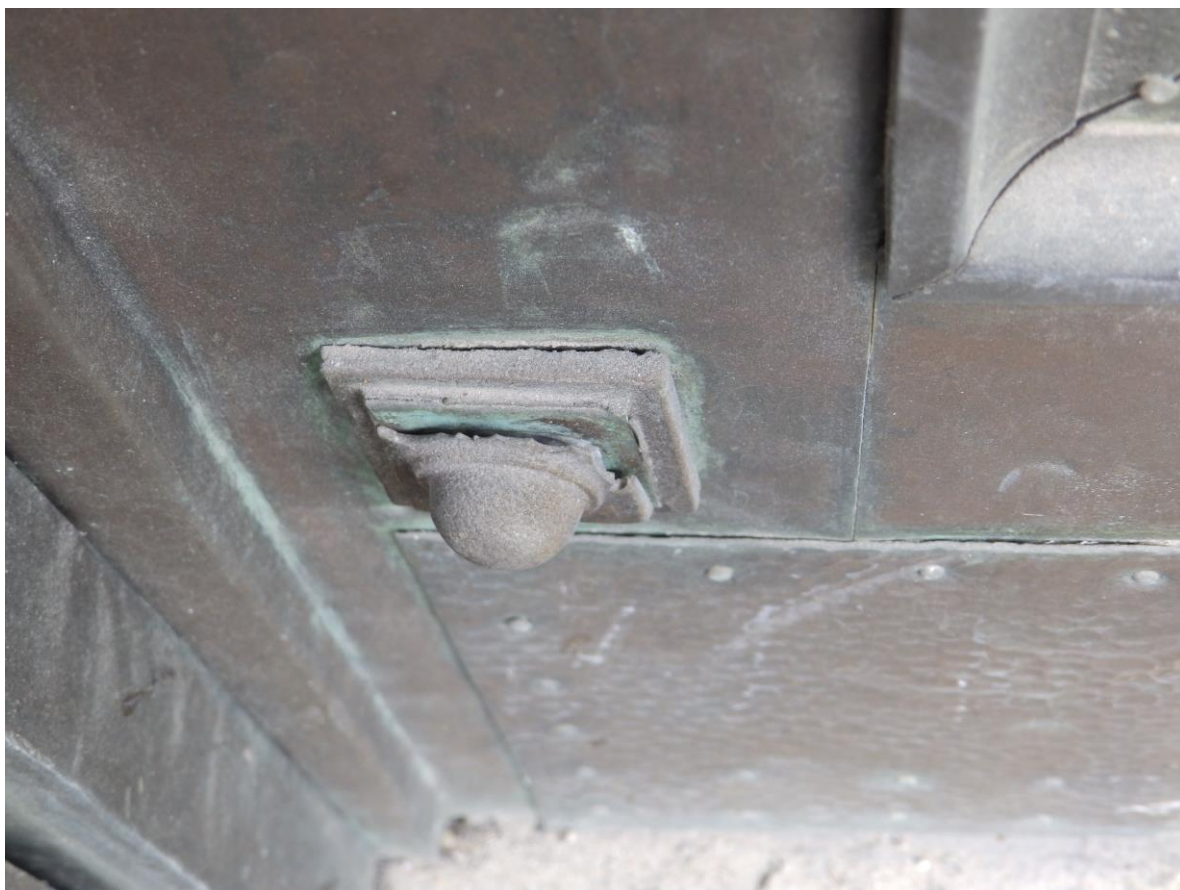
Obrázek 17: Detail degradace zdobného prvku
