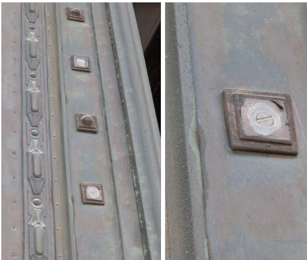
Obrázek 19: Chybějící zdobné prvky před restaurováním
